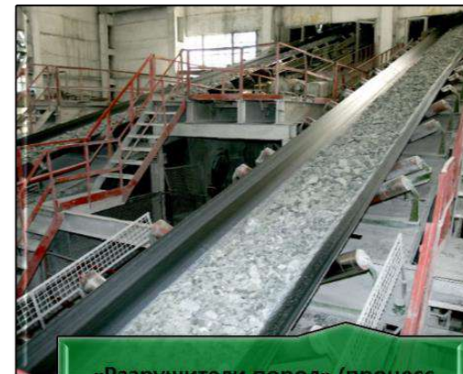
«Разрушители пород» (процесс обогащения руды на асбестообогатительной фабрике)
