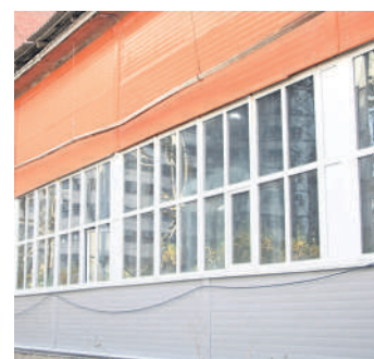
Обновленное здание цеха готовой продукции асбесто-обогащительной фабрики
