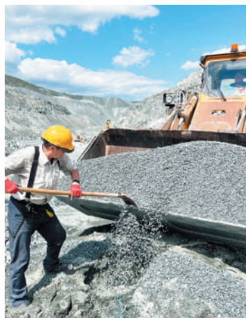
После зарядки эмульсионным взрывчатым веществом скважину засыпают щебнем. Это позволяет удержать силу взрыва еще на несколько миллисекунд внутри массива для дробления породы
