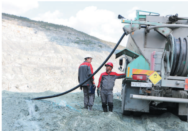
Смесительно-зарядные машины наполняют взрывчатым веществом скважины, при этом ручьями из них вытекает вода. Из-за глубины разработки карьера скважины практически все обводнены. Поэтому за зарядкой - особый контроль
