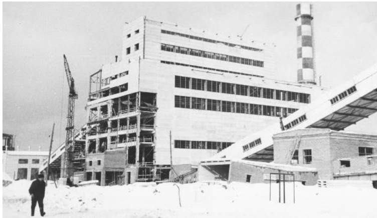
Строительство фабрики: корпус приводных станций, галерея №2, корпус III-IV стадии дробления, галерея №5. Март 1966 года.
