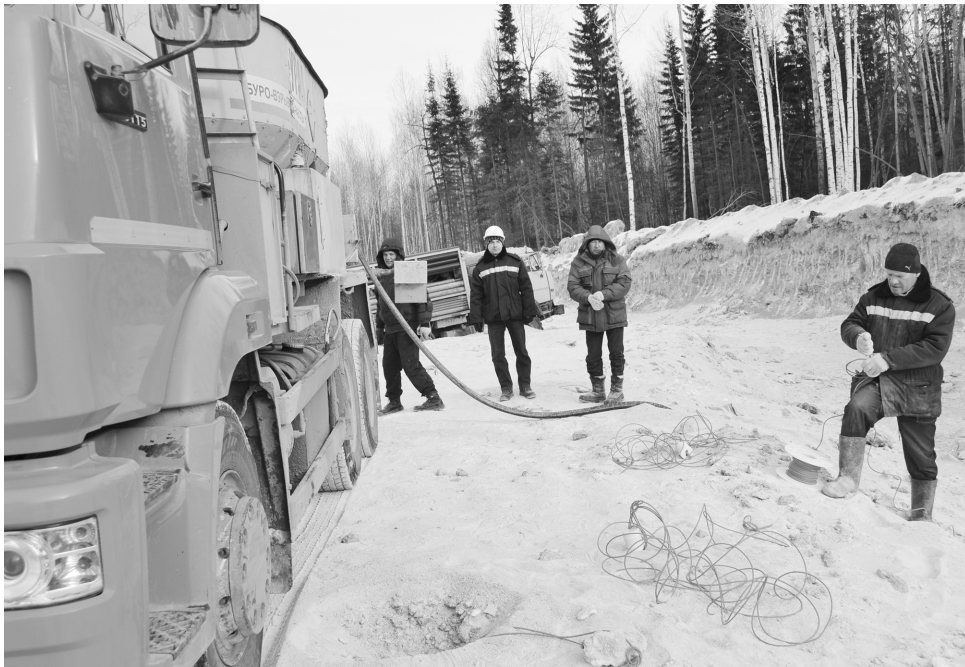
Бригада взрывников закладывает в скважины детонирующий шнур.
